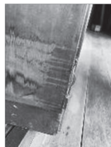
古民家建具修理
