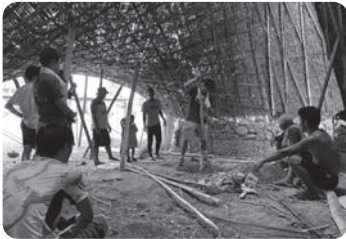
現地の人たちと学生による建設作業（08/06）
