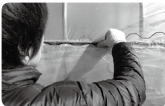
ビニールハウス修繕 (03/04)
